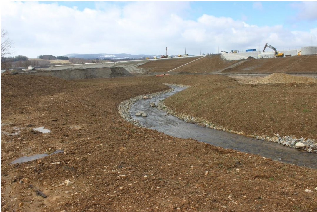
Fot.2. Nowe koryto potoku Nowinka, skarpy potoku zostały zahumusowane i obsiane mieszanką traw – etap realizacji Kontraktu.
