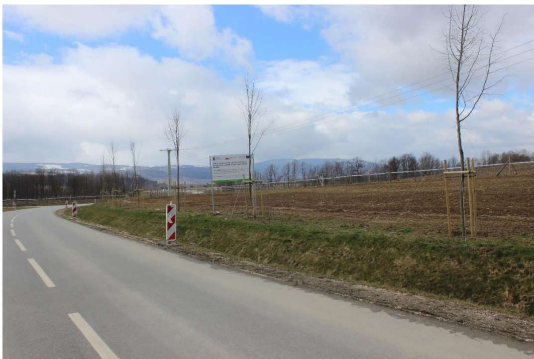
Fot.3. Wybudowany nowy odcinek drogi powiatowej 3233D. Wzdłuż drogi widoczne są nasadzenia drzew – etap realizacji Kontraktu.
