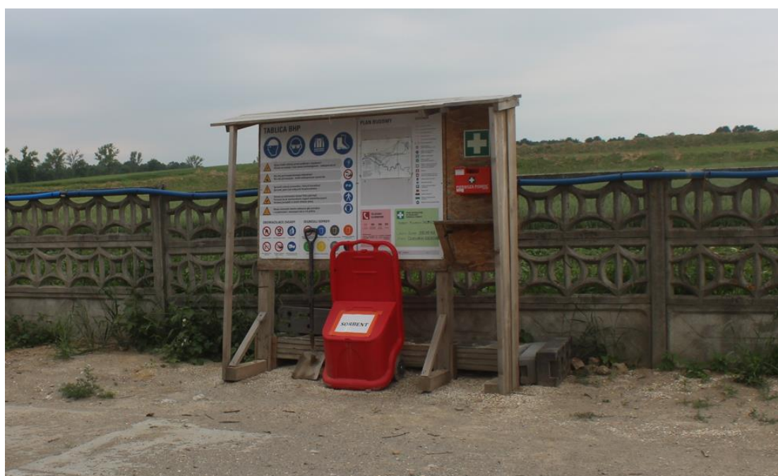
Fot.6. Punkt BHP zlokalizowany na zapleczu budowy – etap realizacji Kontraktu.
