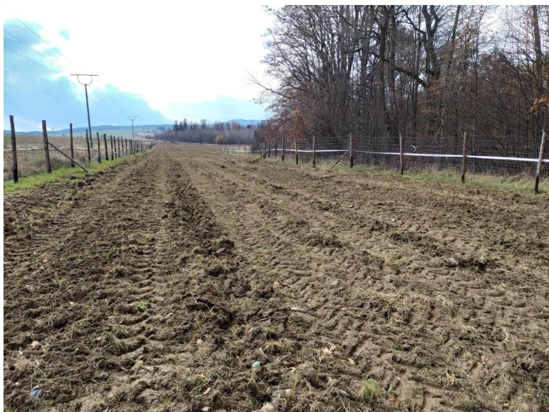
Fot.4. Jedna z powierzchni kompensacyjnych na terenie inwestycji. Obszar został ogrodzony i przygotowany pod wykonanie kompensacji przyrodniczej – etap realizacji Kontraktu.
