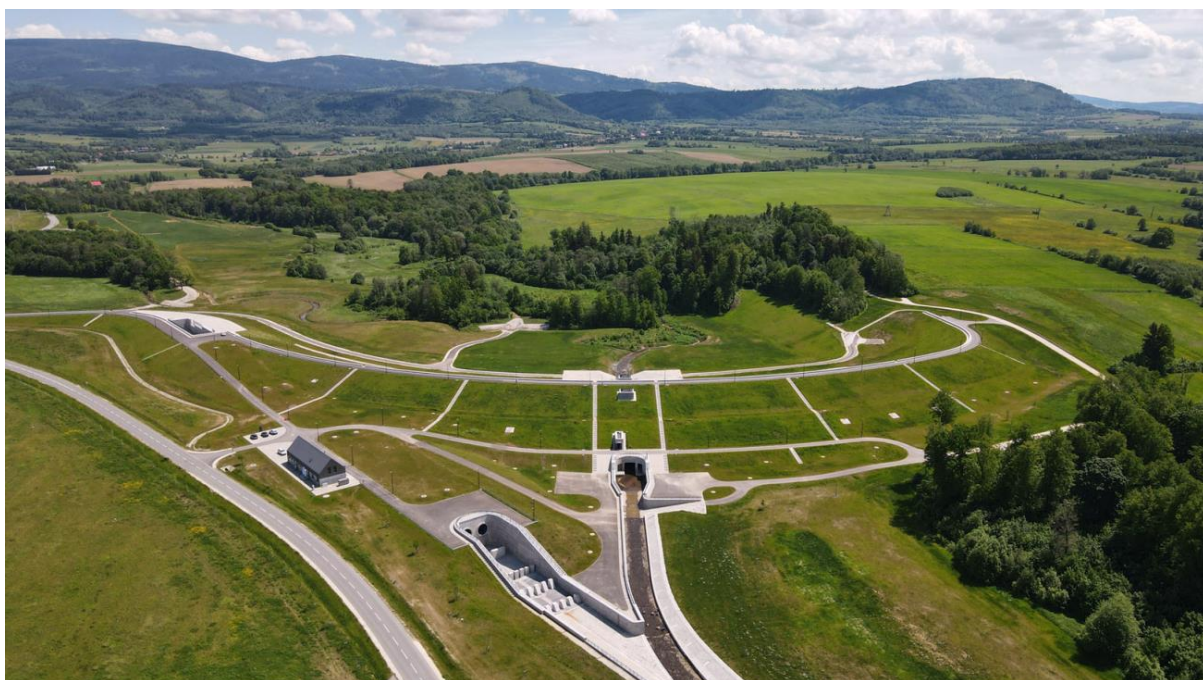
Fot.11. Zbiornik przeciwpowodziowy od strony zachodniej, etap eksploatacji (Okres Zgłaszania Wad) – maj 2022 r.
