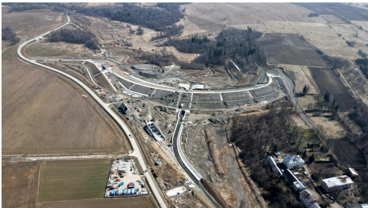
Fot.10. Realizacja robót dla Kontraktu 2A.1/2 – marzec 2021 r.
