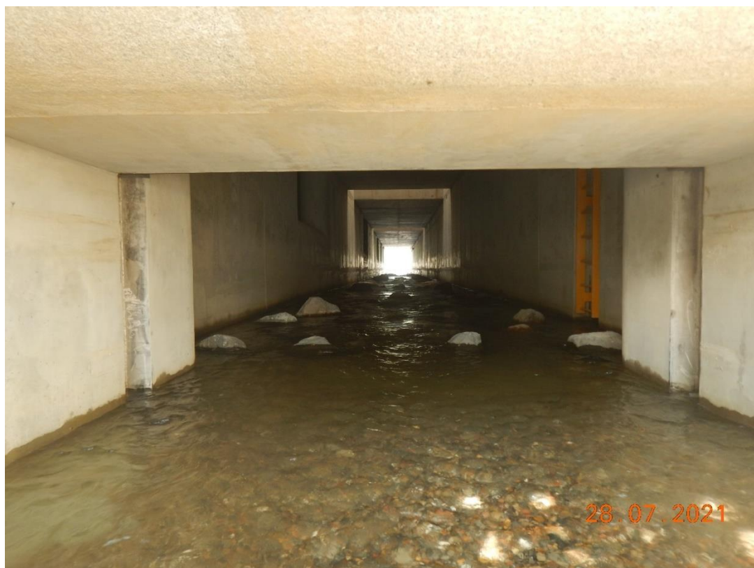
Fot.5. Układ dna potoku Goworówka w sztolni pod zaporą zbiornika – etap realizacji Kontraktu.
